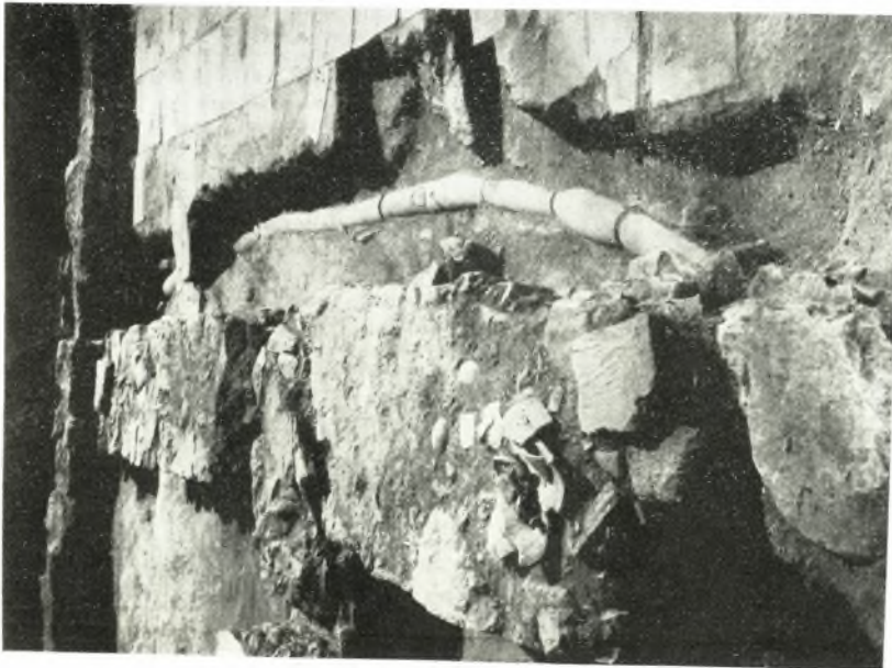
α. Τὸ ἀνατολικὸν τμήμα τοῦ ἀγωγοῦ.
