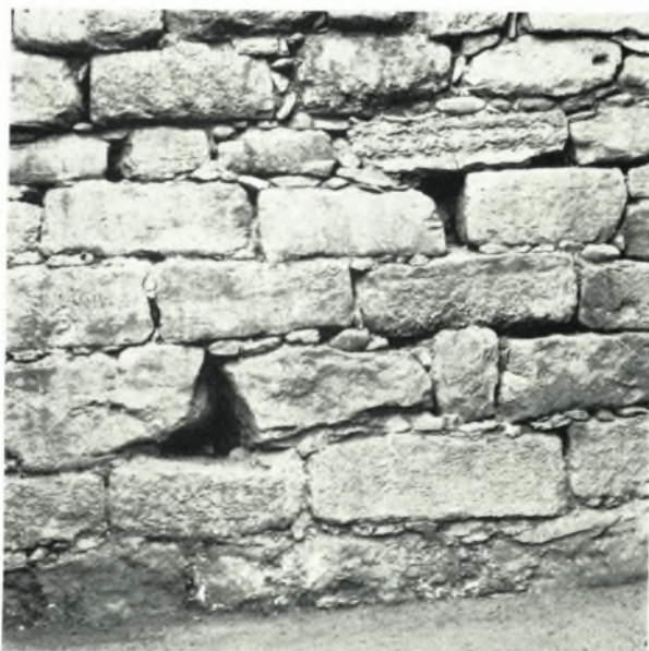
β. Ἡ ἀνατολικὴ πλευρὰ τῆς θόλου. Ἐπὶ τοῦ κατωτάτου δόμου διακρίνεται ἔνιαγού ἢ ἐκ κονιάματος ἐπίχρσις.
