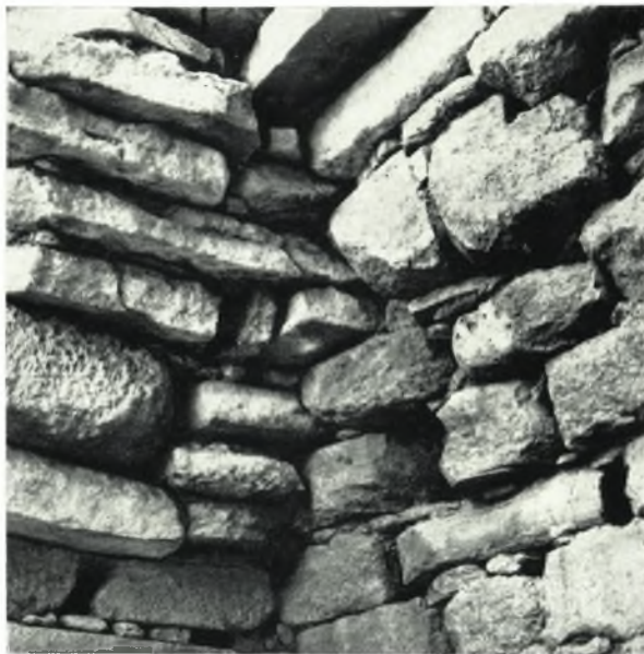
α. Ἡ ΒΑ. γωνία τῆς θόλου. Λεπτομέρεια δομῆς τῆς πυραμιδοειδοῦς ὀροφῆς.
