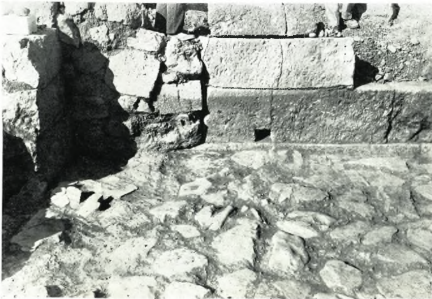
β. Ἡ Β. γωνία τῆς πλακοστρώτου αὐλῆς I.XIV μετὰ τῆς φραχθείσης θύρας.
