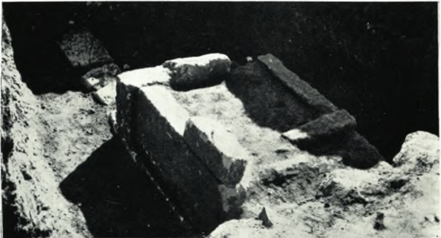
β. Δυτικὸς τοῖχος πύργου τοῦ παραθαλασσίου τείχους. Ἄποψις ἀπὸ Βορρᾶ.
