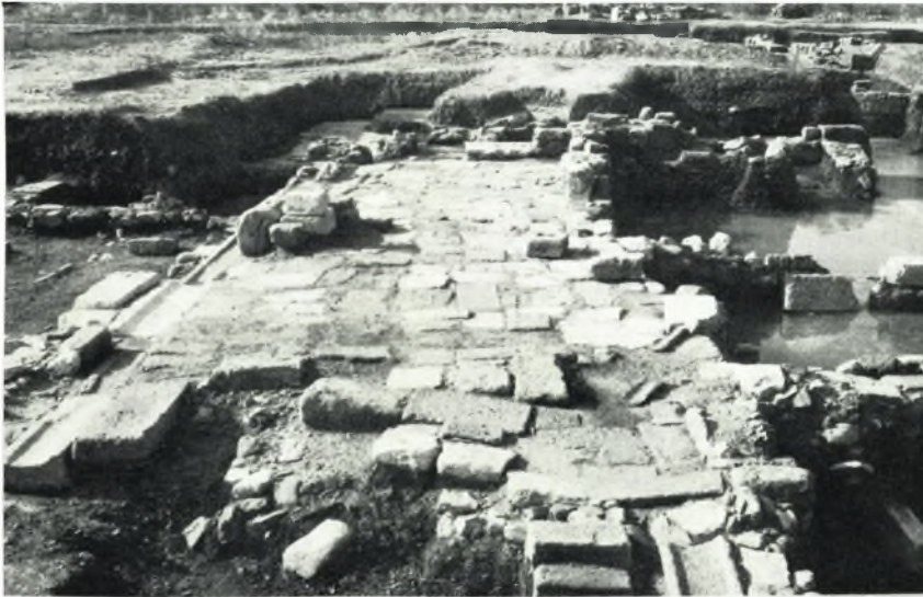
β. Πλακόστρωτον καὶ τοῖχοι ρωμαϊκῶν οἰκιῶν ἀνατολικῶς καὶ νοτίως τῆς κλασσικῆς οἰκίας.
