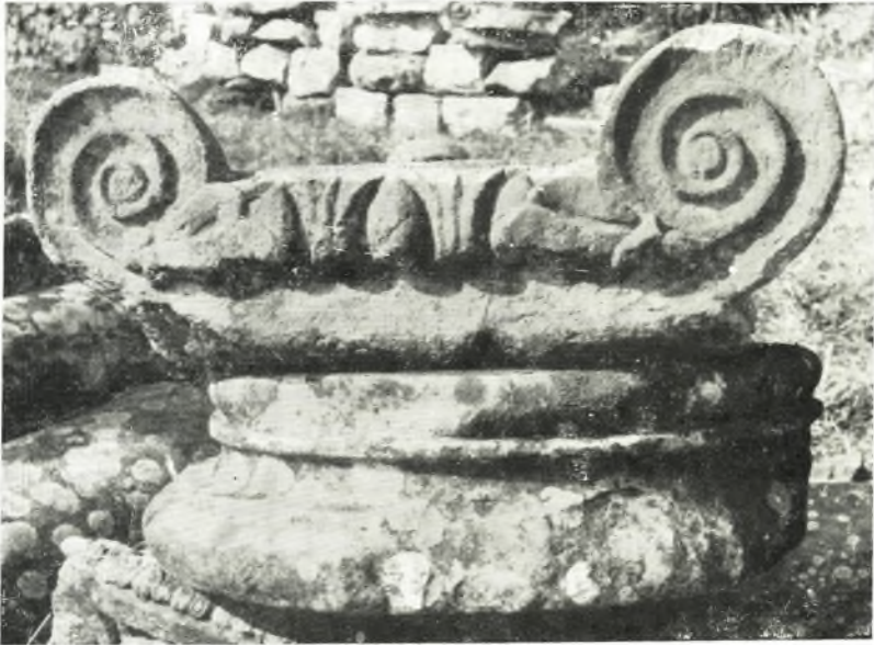
α. Ίωνική βάση και κιονόκρανον ἐκ τῶν κιονοστοιχιῶν τοῦ περιστυλίου.
