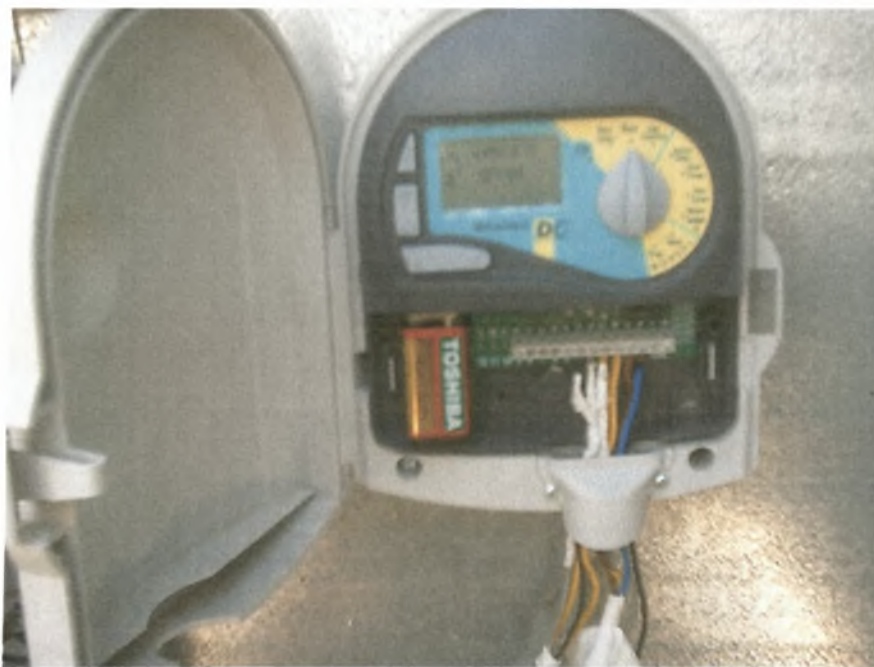
Εικόνα 4.4 Προγραμματιστής Miracle DG της εταιρείας Netafim
