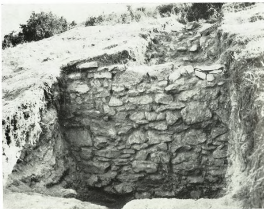
β. Τὸ ἀποκαλυφθὲν τμῆμα τοῦ τείχους.
