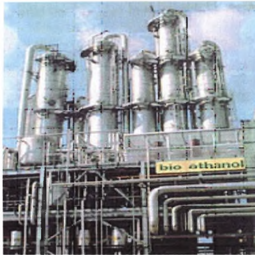
Εικ. 42. Εργοστάσιο επεξεργασίας βιοαιθανόλης
