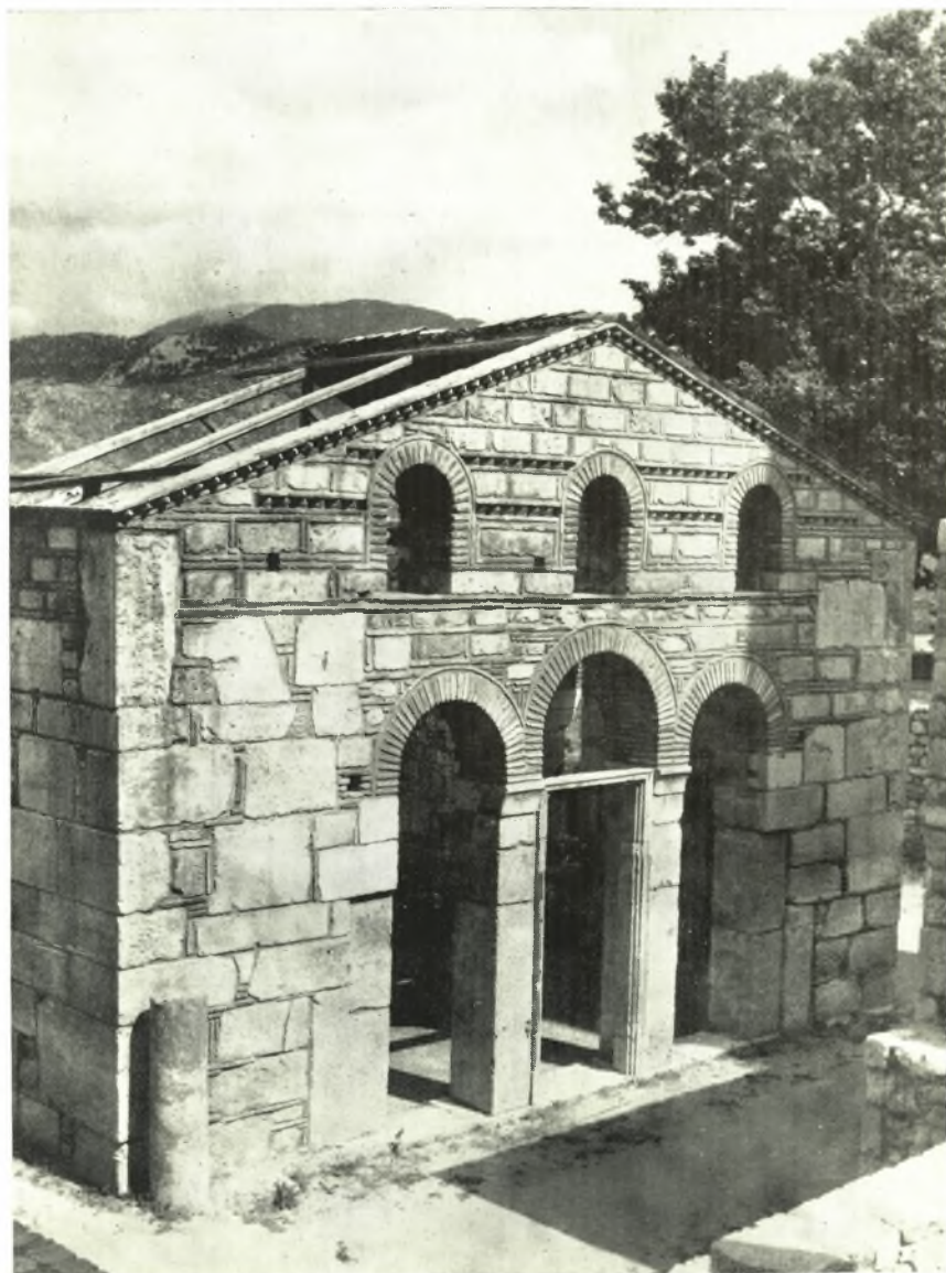
Ἐποψὶς τῆς Τραπέζης ἀπὸ ΒΔ. μετὰ τὰς ἐργασίας ἀναστηλώσεως.
