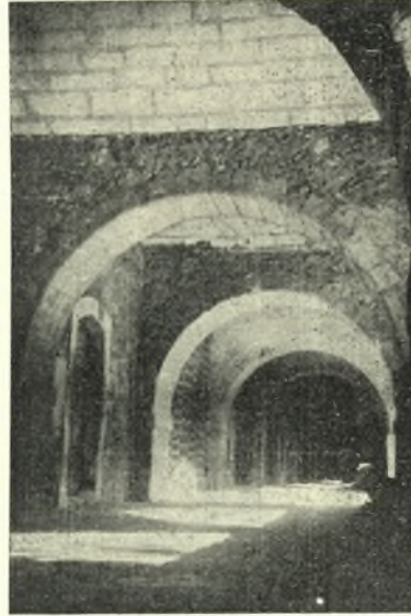
Εἰκ. 28. Ἀρχάδι. Τὰ δυτικὰ Κλάουστρα μετὰ τὴν ἀναστήλωσιν.
