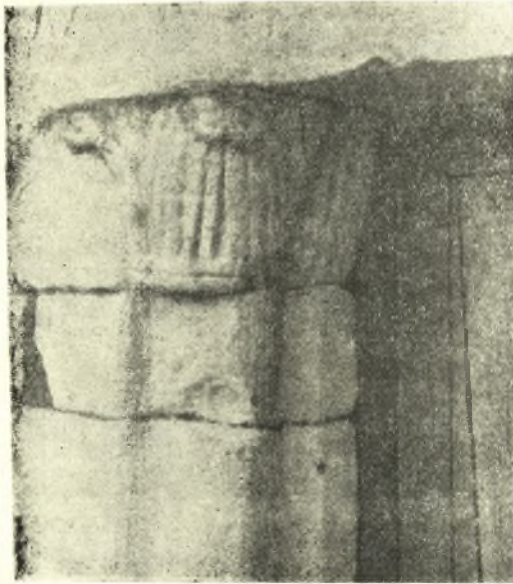
Εἰκ. 28. Παναγία «Ραχιώτισσα» Φλιούντος. Σταθμὸς τῆς δυτικῆς θύρας.
