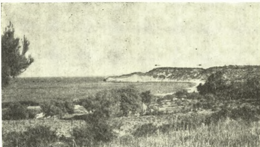
Εἰκ. 1. Τὸ ἀκρωτήριο «Ἀσκηταριό» παρὰ τὴν Ραφήναν (Διὰ βελῶν σημειοῦται ὁ χώρος τῆς ἀκροπόλεως).
