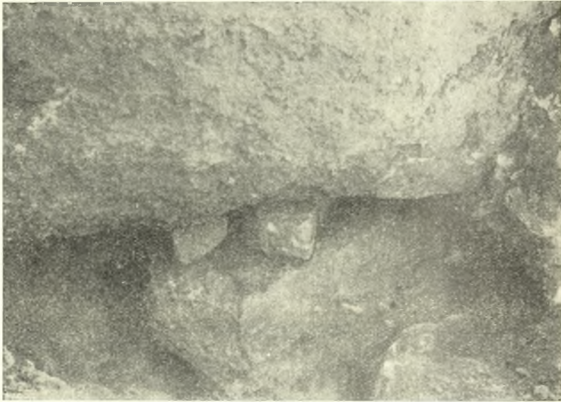
Εἰκ. 5. Τὸ ὀπίσθιον τμήμα τοῦ τοίχου τῆς εἰκ. 4 μετὰ σφηνίσκων μεταξὺ τῶν ὑπερκειμένων δόμων τῶν λίθων.
