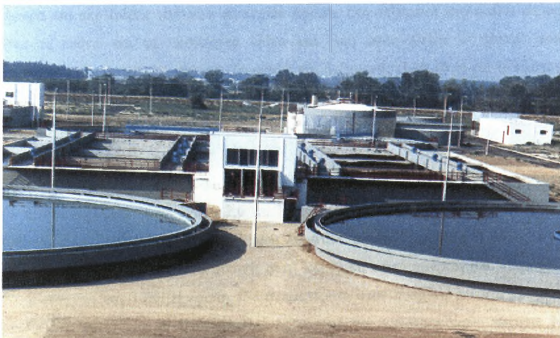
Εικόνα 4.1: Άποψη της εγκατάστασης επεξεργασίας λυμάτων του δήμου Λάρισας.
