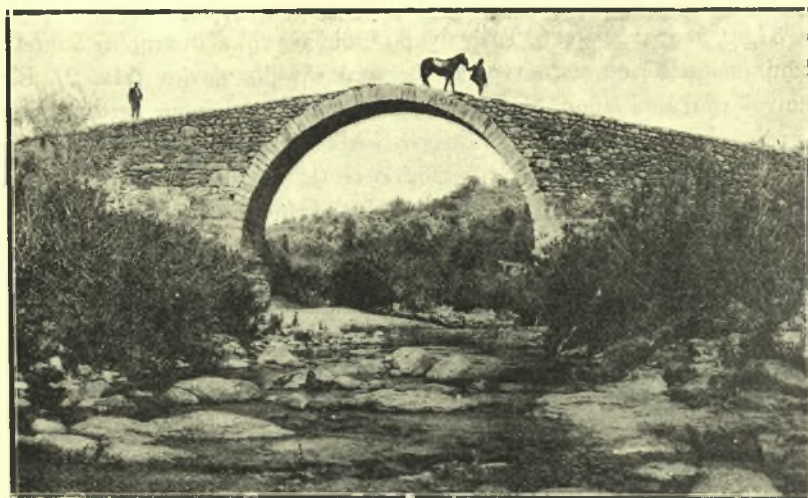
Εἰκ. 3. Γέφυρα ἁγ. Θεράποντος παρὰ τὴν Κλοπεδὴν Λέσβου.
