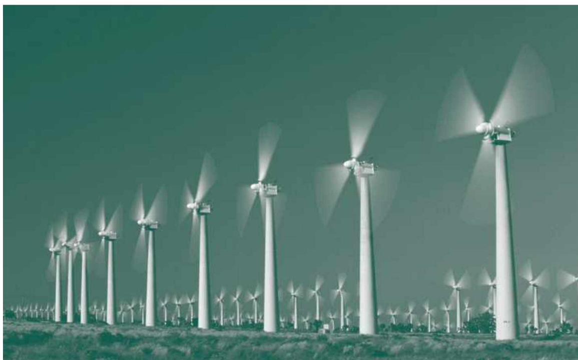
Εικόνα 1.1 Παραγωγή ηλεκτρικής ενέργειας από Α/Γ
