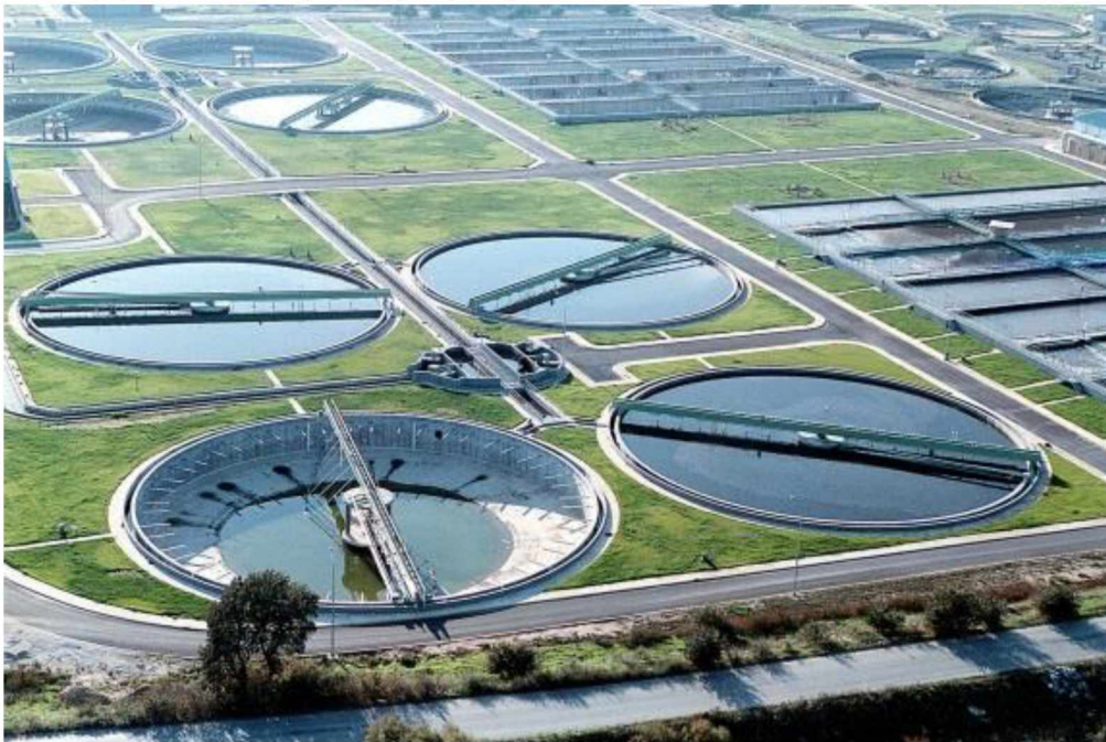
Εικόνα 2: Σύγχρονες εγκαταστάσεις βιολογικού καθαρισμού
