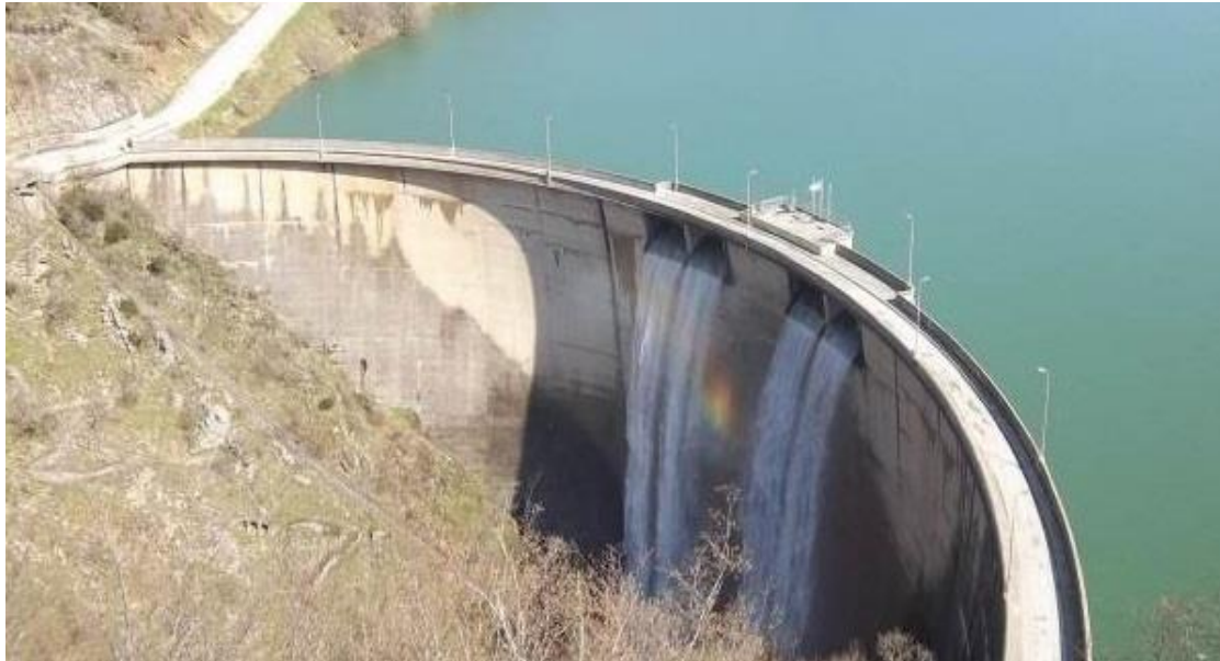
Εικόνα 36: Οι υπερχειλιστές του φράγματος Πλαστήρα σε λειτουργία. Ανάκτηση από: https://geo.civ.uth.gr/images/documents/plastira01.pdf .
