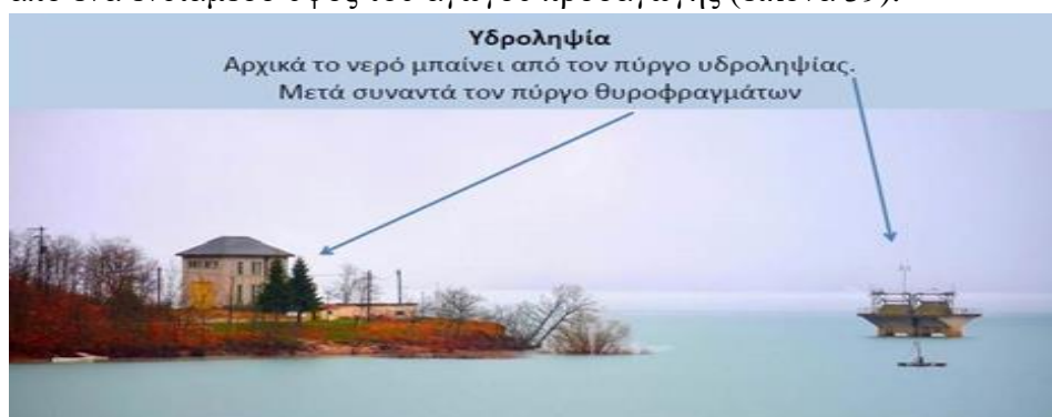
Εικόνα 38: Το σημείο της υδροληψίας. Φαίνεται ο πύργος υδροληψίας (αριστερά) και ο πύργος με τα υποθαλάσσια θυροφράγματα (δεξιά). Ανάκτηση από: https://geo.civ.uth.gr/images/documents/plastira02.pdf .
