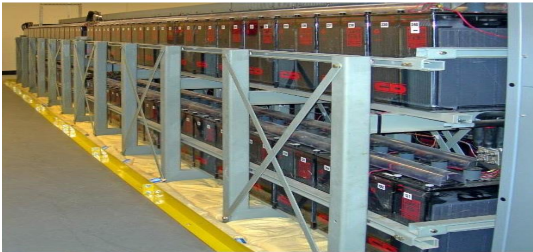
Εικόνα 299: Το σύστημα των εφεδρικών συσσωρευτών σε έναν υδροηλεκτρικό σταθμό. Ανάκτηση από: https://mercomindia.com/2015-2018-saw-70-dip/
