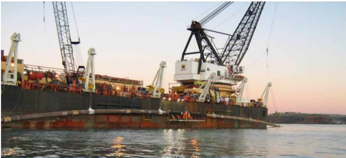
Σχήμα1. 2 Ο αγωγός μεταφοράς φυσικού αερίου Medgaz
