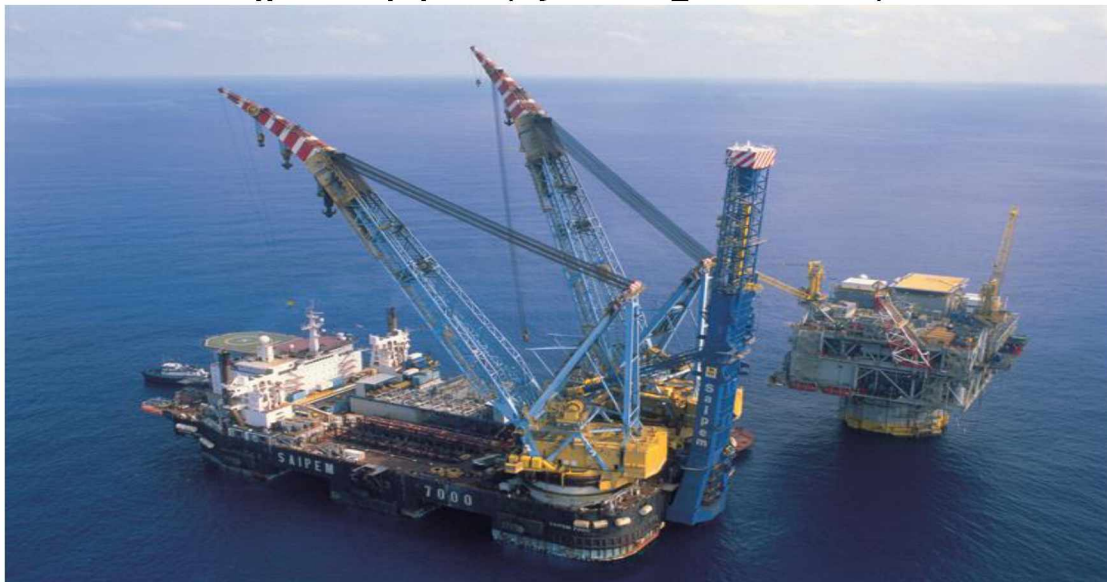
Σχήμα1. 6 Η φορτηγίδα Saipem 7000 με πύργο για εγκατάσταση αγωγού με J-Lay (Kyriakides_Corona 2007)
