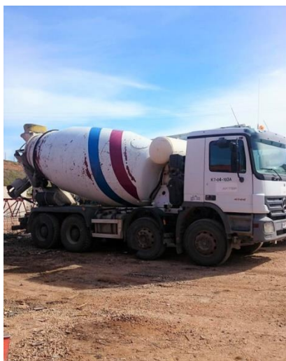
Εικόνα 9.2 Βαρέλα μεταφοράς μπετού στο εργοτάξιο της ΣΓ26 (Πηγή: Ίδια επεξεργασία)
