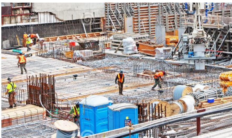
Εικόνα 7.1 Εργοτάξιο οικοδομής στο κέντρο της πόλης Τορόντο (Πηγή: Google)
