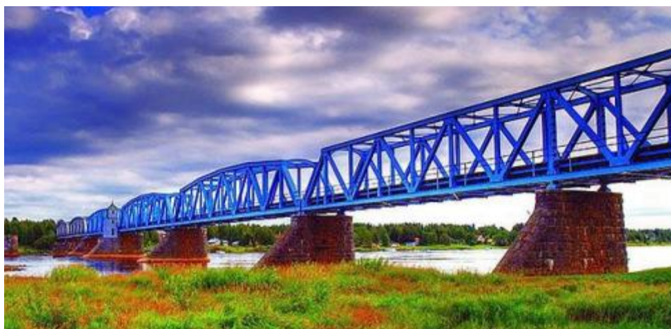
Εικόνα 4.5 Η Σιδηροδρομική Γέφυρα Harjavalta – Tornio, Σουηδία – Φινλανδία (Πηγή: Google)
