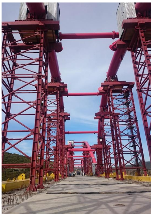
Εικόνα 8.3 Φωτορεαλιστική απεικόνιση υποστηριγμάτων τόξων (Πηγή: Ίδια επεξεργασία)
