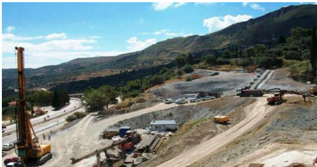
Εικόνα 7.3 Εργοτάξιο Ολυμπίας οδού (Πηγή: Άκτωρ ΑΤΕ)
