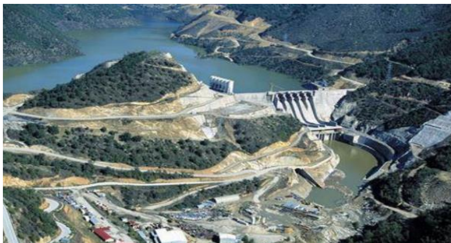
Εικόνα 7.6 Φράγμα θησαυρού στον ποταμό Νέστο (Πηγή: Άκτωρ ΑΤΕ)
