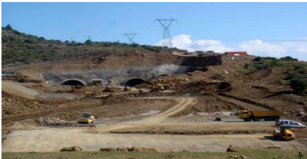
Εικόνα 7.4 Εργοτάξιο Σήραγγας Μακύνειας, Ιόνια Οδός (Πηγή: ΤΕΡΝΑ ΑΕ)
