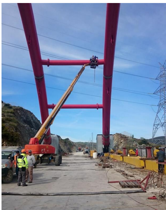
Εικόνα 9.5 Καλαθοφόρος γερανός στο εργοτάξιο της ΣΓ26 (Πηγή: Ίδια επεξεργασία)
