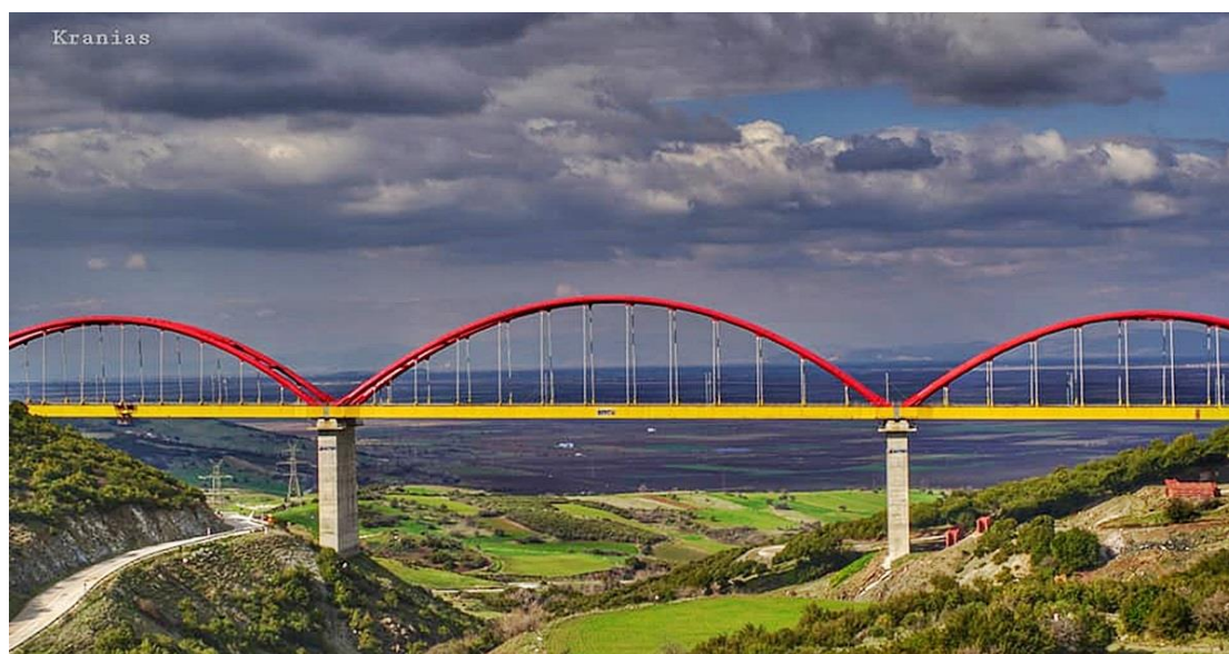
Εικόνα 9.8 Τελική κατασκευή της ΣΓ26 (Πηγή: ΕΡΓΟΣΕ Α.Ε, 2018)
