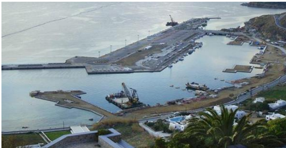
Εικόνα 7.5 Εργοτάξιο νέου λιμένα Μυκόνου (Πηγή: Ακτωρ ΑΤΕ)
