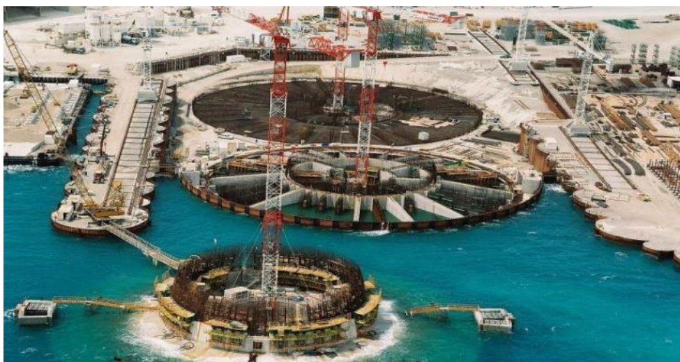
Εικόνα 7.7 Εργοτάξιο γέφυρας Ρίου – Αντιρρίου (Πηγή: Vinci S.A.)
