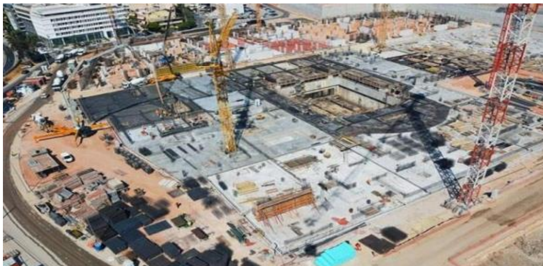
Εικόνα 7.2 Εργοτάξιο Κέντρου Πολιτισμού Ιδρύματος Σταύρος Νιάρχος (Πηγή: ΤΕΡΝΑ Α.Ε)
