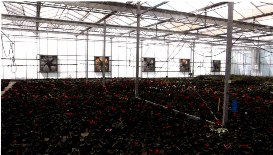
Εικόνα 1.2 Εξαεριστήρες θερμοκηπίων
