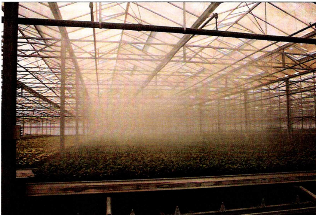
Εικόνα 1.4 Πολύ λεπτές σταγόνες που δημιουργεί το σύστημα ομίχλης μειώνουν την θερμοκρασία
