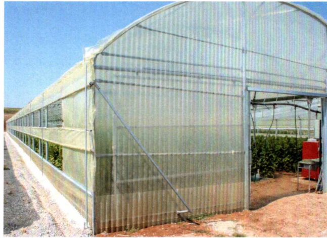
Εικόνα 1.1 Φυσικός εξαερισμός με πλευρικά παράθυρα
