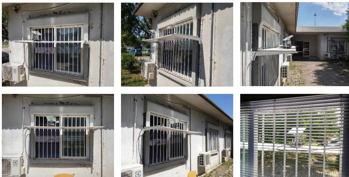
Εικόνα 78: Εξωτερικές φωτογραφίες της εγκατάστασης του πρωτοτύπου συστήματος ηλιοστάτη/ηλιακού ιχνηλάτη (ΜΑΚV1).
