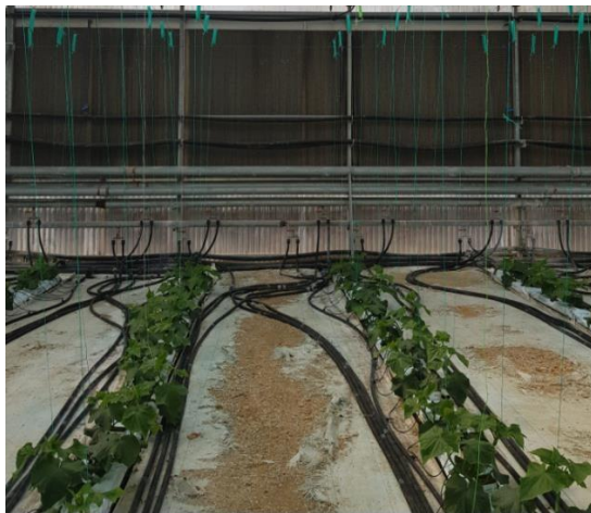
Εικόνα 12. Μεταφορά θερμού νερού μέσω μεταλλικών σωλήνων (αριστερά) και πλαστικών σωλήνων (δεξιά)
