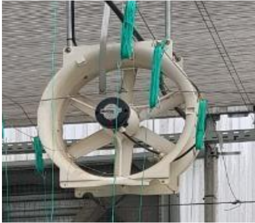
Εικόνα 11. Ανεμιστήρας ανάμειξης του αέρα (αριστερά) και παράθυρα οροφής (δεξιά).
