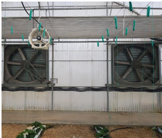
Εικόνα 10. Ανεμιστήρες δυναμικού αερισμού (αριστερά) και σύστημα υγρής παρειάς (δεξιά).
