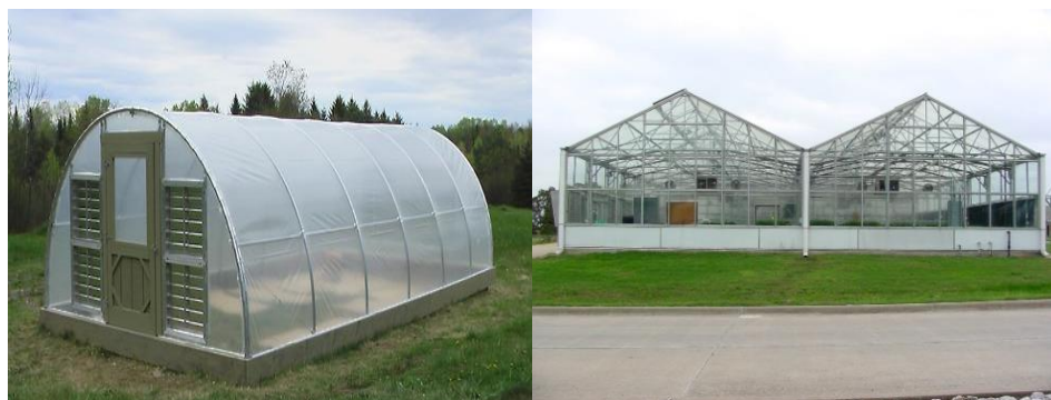
Εικόνα 1. Τύποι θερμοκηπίων με βάση το σχήμα της κατασκευαστικής μονάδας. Τοξωτό θερμοκήπιο (αριστερά, Πηγή 1) και αμφικλινές θερμοκήπιο (δεξιά, Πηγή 2).
