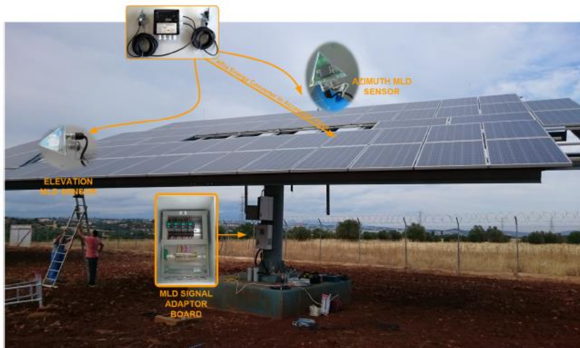
Εικόνα 2.8γ: Παρακολούθηση ηλίου “Tracker dual axis” με το σύστημα της degerhellas. [12]
