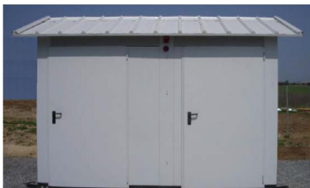
Εικόνα 4.16β: Υποσταθμός Μ.Τ. Φ/Β 500kW. [24]
