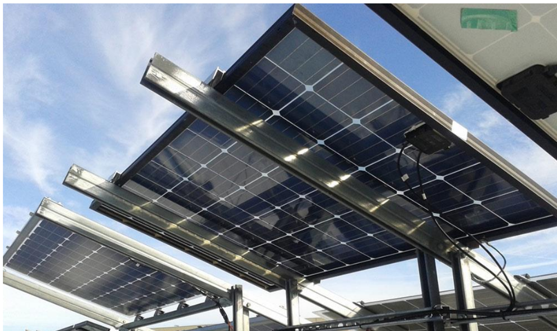
Εικόνα 1.4: Φωτοβολταϊκά στοιχεία bifacial (πηγή: solarreviews.com)
