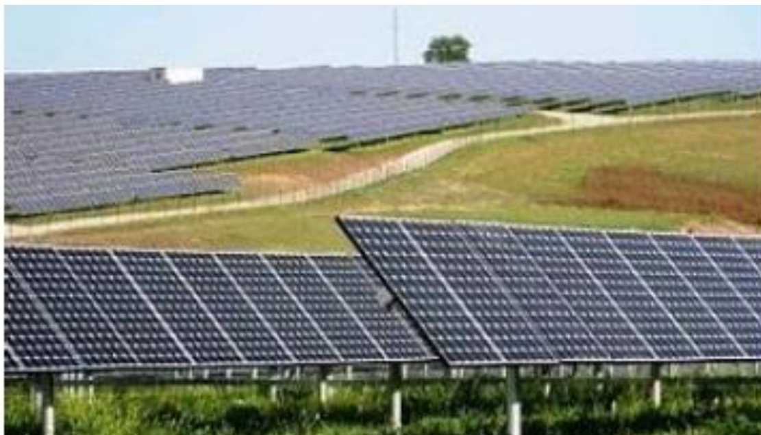
Εικόνα 2.1: Σύστημα σταθερών ηλιακών συλλεκτών [2]
