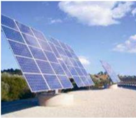
Εικόνα 2.4α: Σύστημα «tracker» με παρακολούθηση ηλιακής τροχιάς διπλού άξονα (X και Y άξονα). [10]
