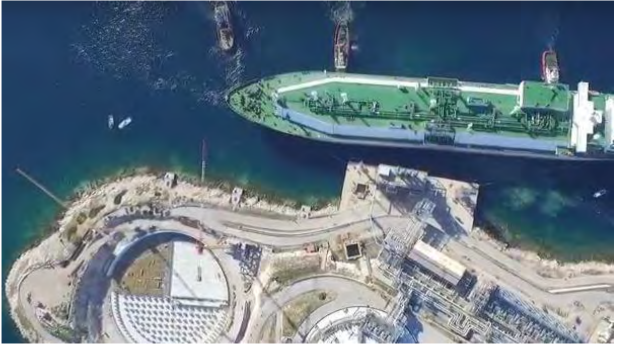
Εικόνα 1.6 LNG Terminal Ρεβυθούσας (Πηγή: Huffington Post)
