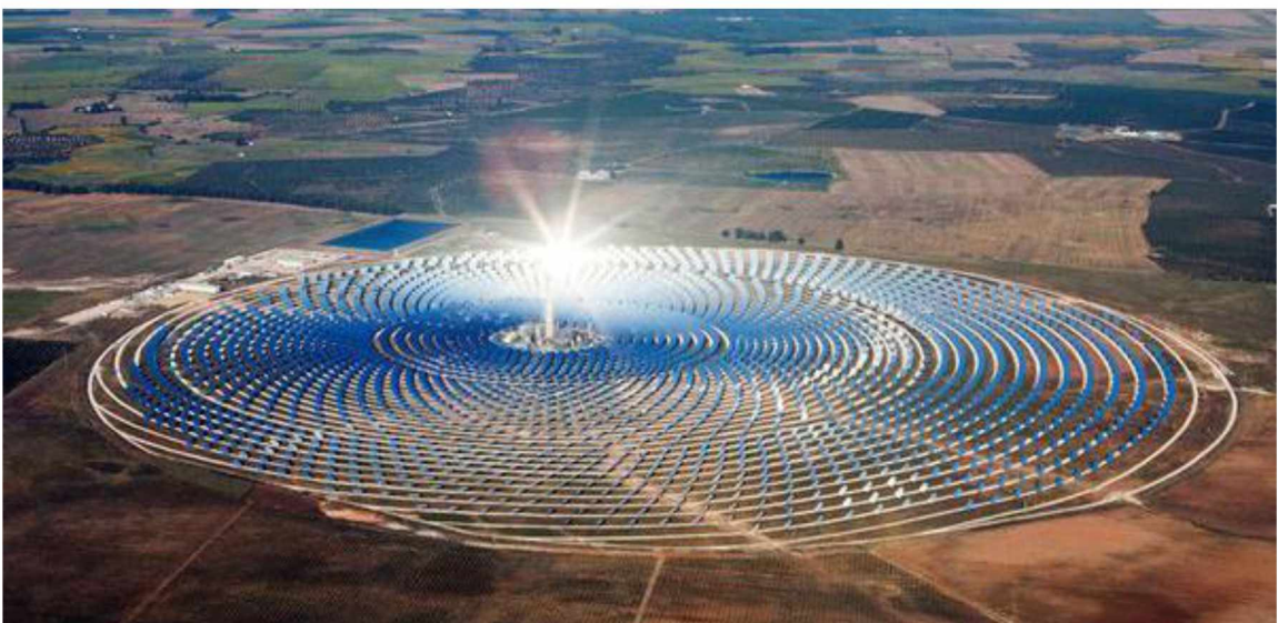
Εικόνα 14: Ηλιακός πύργος ισχύος 260 MW στη Χιλή Πηγή: (EnergyPress, 2015)
