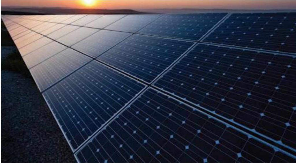
Εικόνα 3: Φωτοβολταϊκά Πηγή: www.economy365.gr
