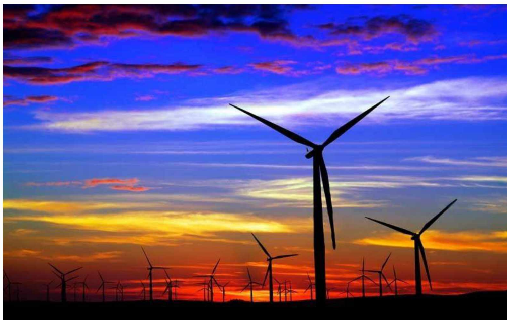
Εικόνα 2: Αιολικό πάρκο Πηγή: www.itossible.gr
