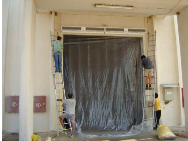
Εικόνα 8: Σφράγισμα των ανοιγμάτων του χώρου. (Από διαφάνειες διαλέξεων Καθηγητή Χ. Γ. Αθανασίου)
