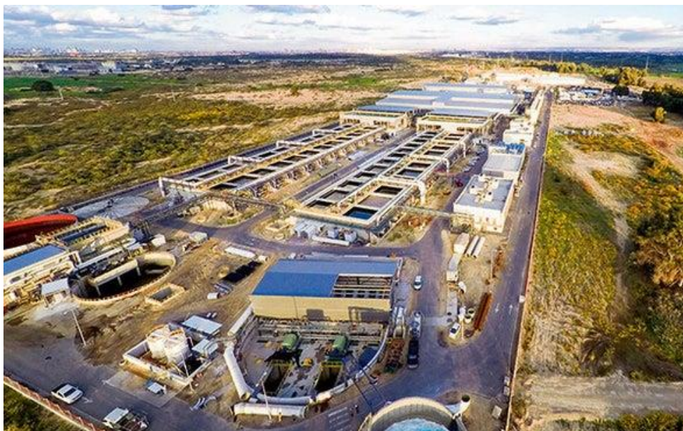
Εικόνα 32: Sorek Desalination Plant, 2016. Πηγή: IDE Technologies.
