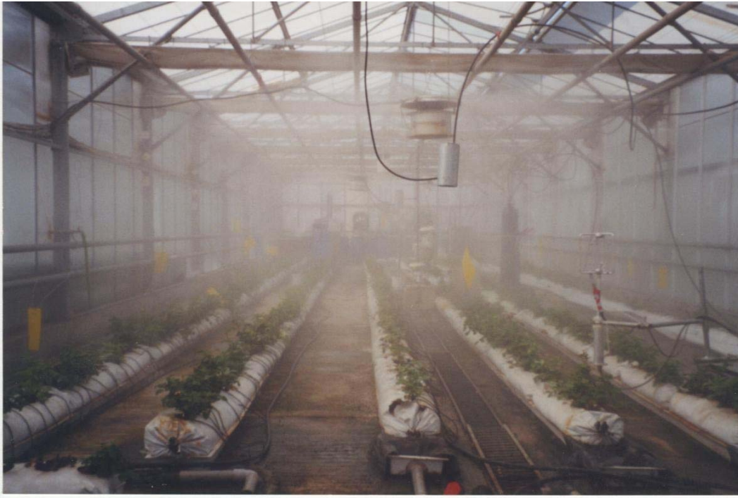
Εικόνα 3.3. Άποψη του εσωτερικού του θερμοκηπίου με το σύστημα δροσισμού σε λειτουργία.
