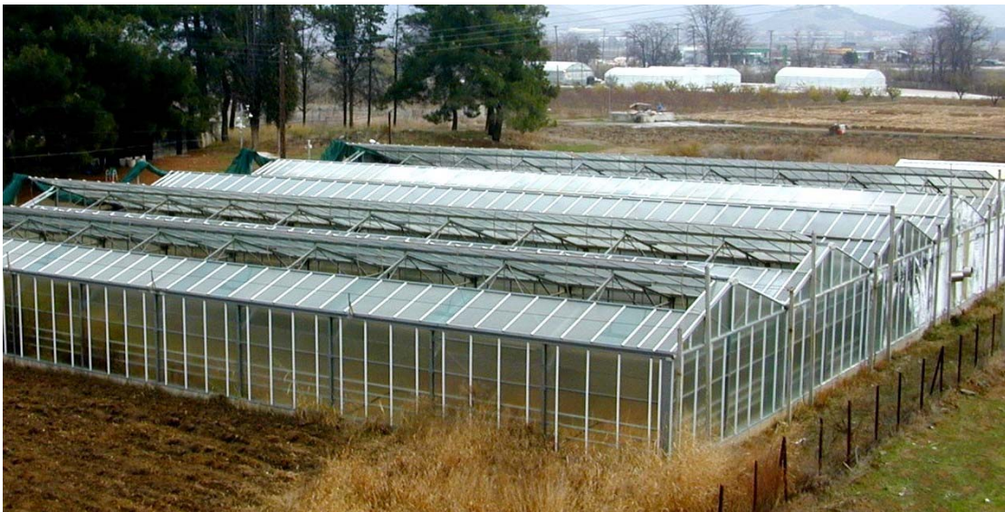
Εικόνα 3.2. Εξωτερική άποψη των παραθύρων οροφής του θερμοκηπίου.
