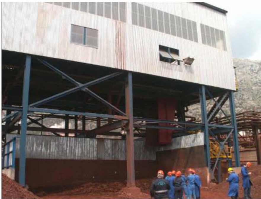
Εικόνα 4.3: Εξωτερική άποψη των εγκαταστάσεων εντός των οποίων στεγάζεται η πρέσα
