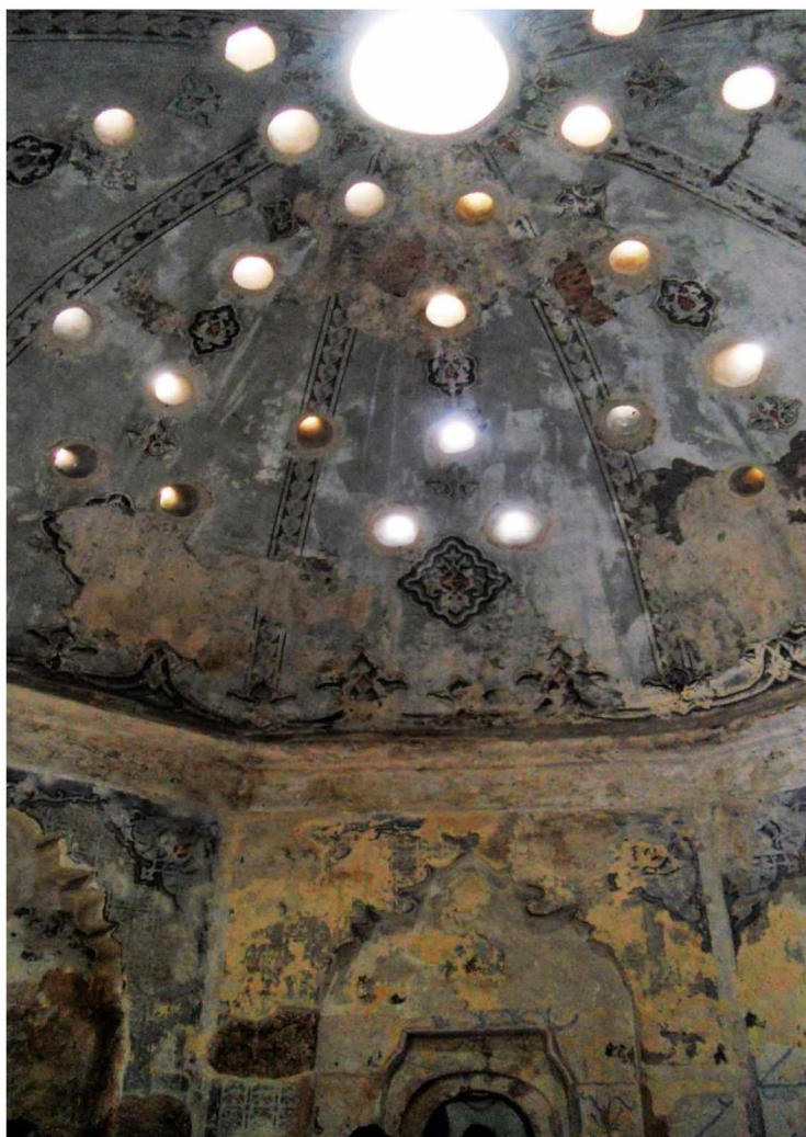
Εκόνα 17 : Το εσωτερικό του Μπέη Χαμάμ στη Θεσσαλονίκη (Φωτογραφία: Μ. Κωστίδη)
