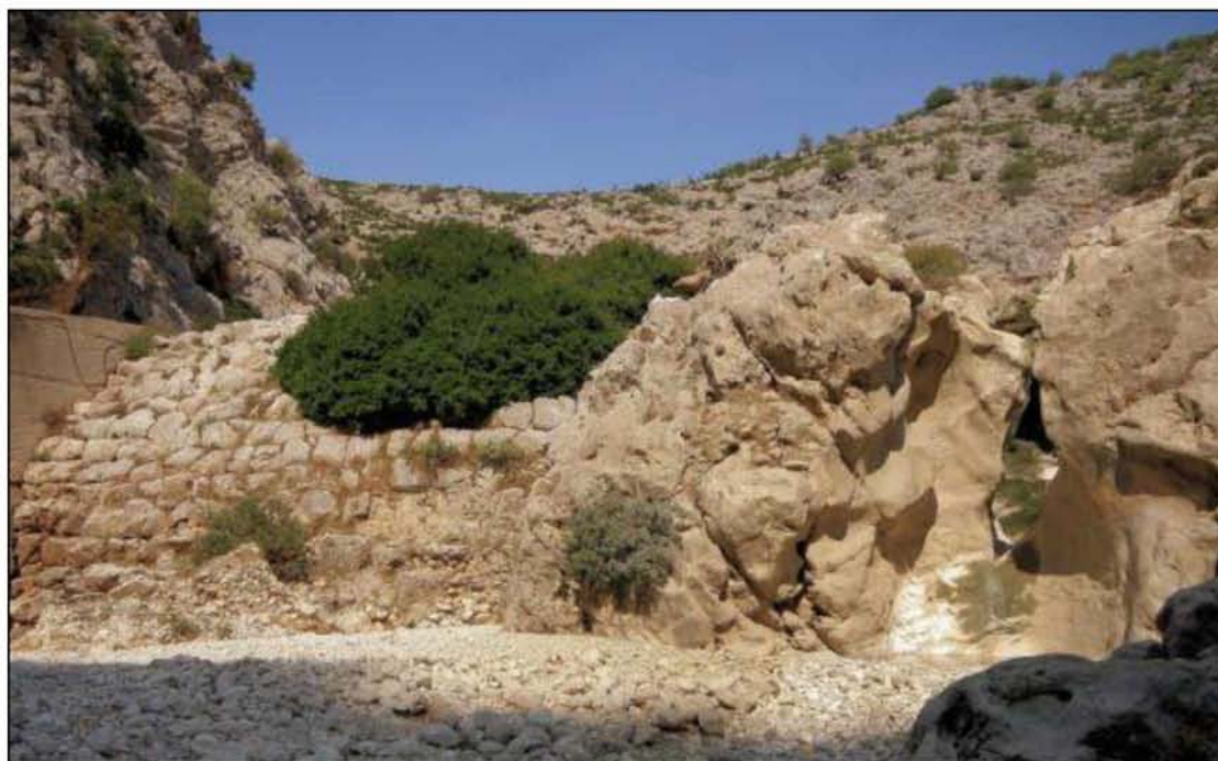
Εικόνα 2: Κατάντη όψη του φράγματος της Αλυζίας στην περιοχή της Αιτωλοκαρναίας
