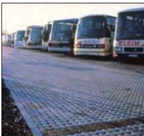
Εικόνα 8: Μονοπάτι διαπερατού οδοστρώματος σε χώρο στάθμευσης στην Παγκόσμια Έκθεση στο Ανόβερο το 2000
