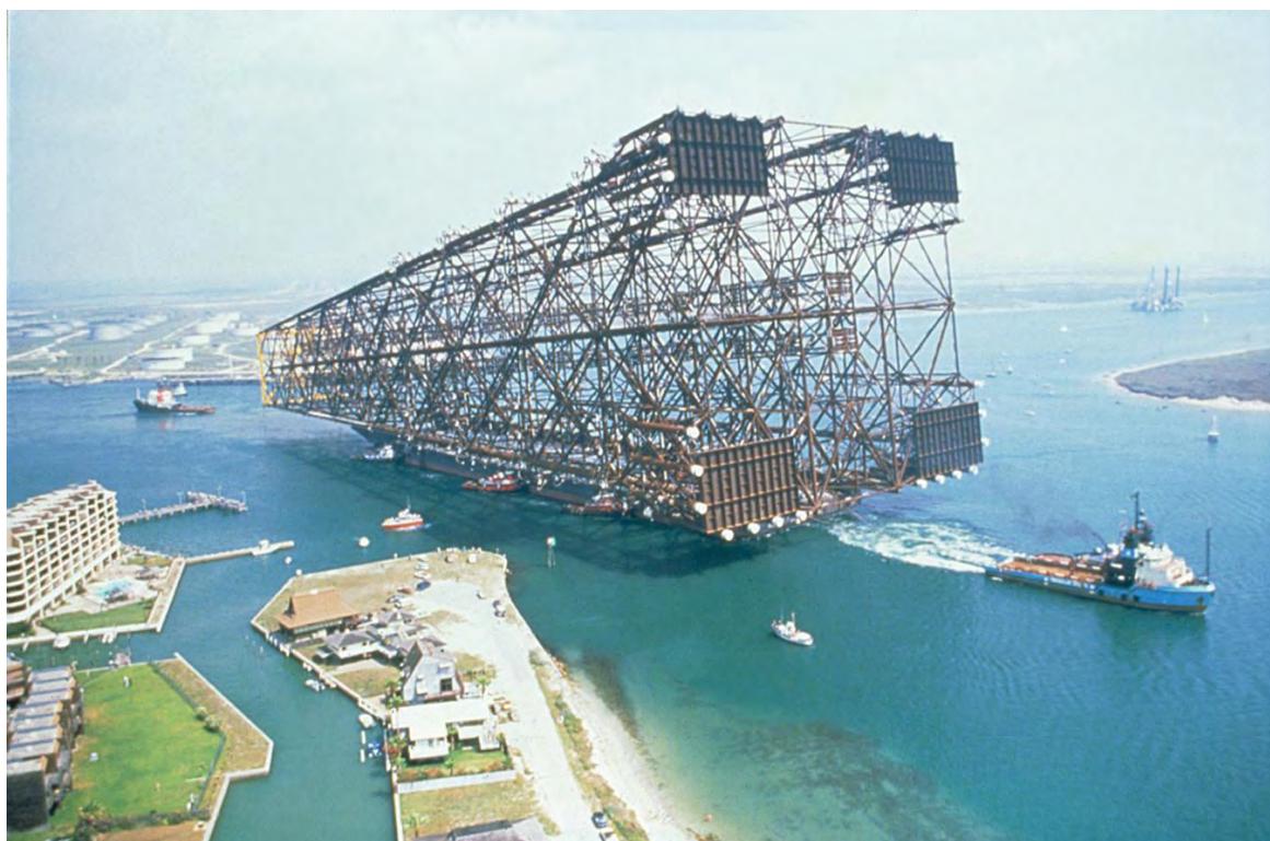
Εικόνα 18: Η Πλατφόρμα τύπου Jacket “Bullwinkle” κατασκευάστηκε και μεταφέρθηκε τμηματικά προς τον Κόλπο του Μεξικού. (Πηγή: Continental Marine Energy, 2019)
