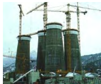
Εικόνα 20: Η κατασκευή της πλατφόρμας “Condeep” στη Βόρεια Θάλασσα. (Πηγή: Berner & Gerwick, 2001)
