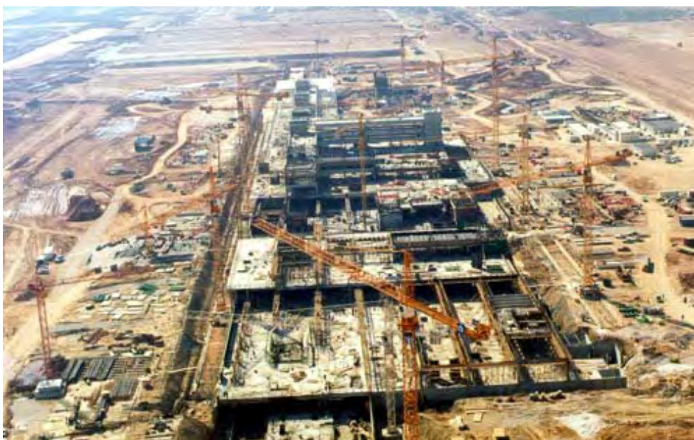
Εικόνα 6 : Η φάση κατασκευής
