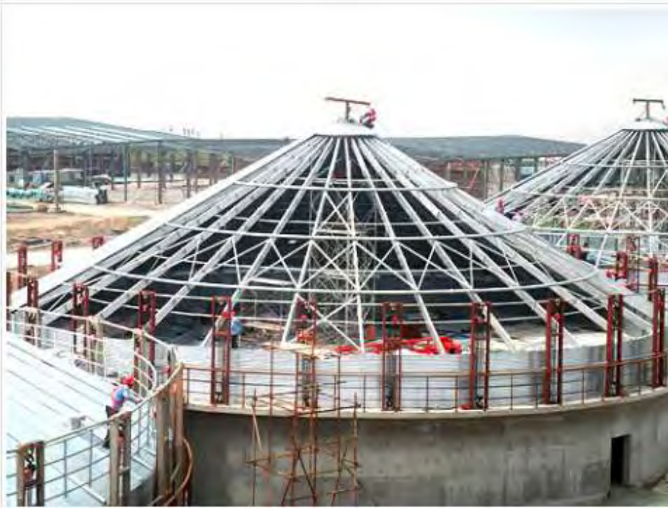
Εικόνα 24 Κατασκευή σιλό με κωνική οροφή ( https://conicalroofs.weebly.com [25])
