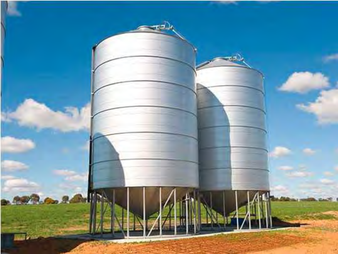
Εικόνα 26 Κατασκευή σιλό με κωνικό πυθμένα ( https://karanasios.eu/silo [27])
