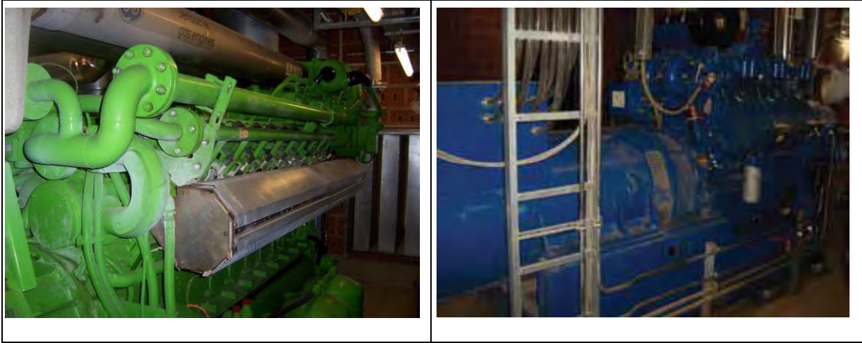
Εικόνα 6.2. Μηχανές αερίου Otto ( πηγή RUTZ 2007)
