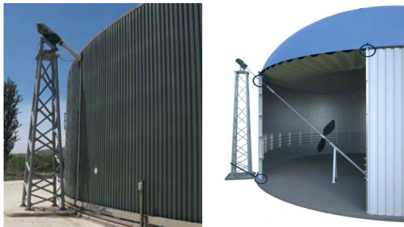
Εικόνα 4.5. : Θέση Αναδευτήρα και επεξήγηση λειτουργίας ανάδευσης ( WELTEC GmbH)
