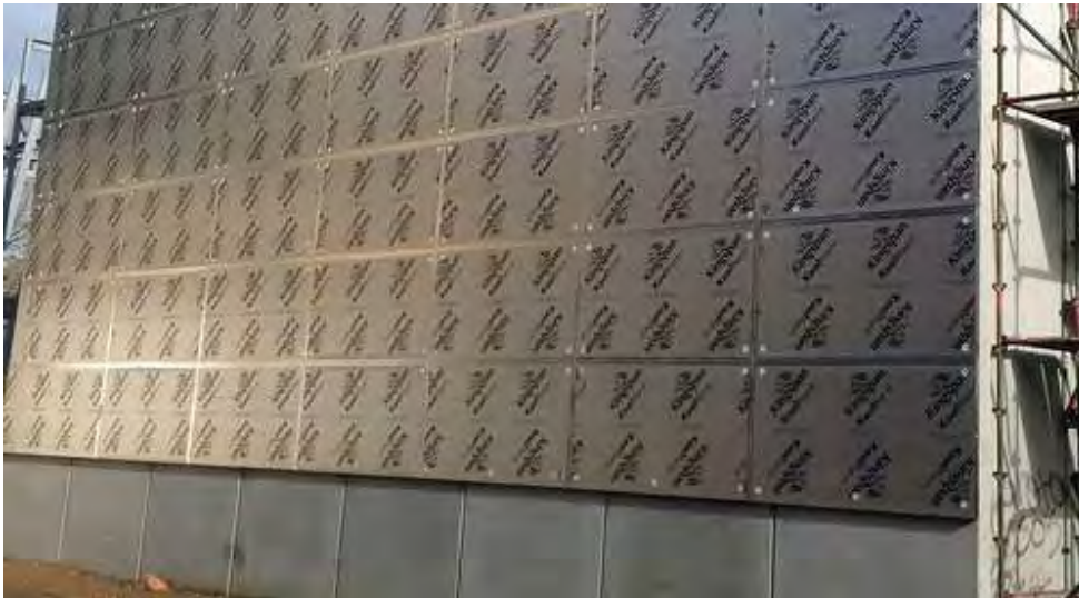
Εικόνα 5.13 Τοποθέτηση θερμομονωτικών πάνελ κενού στην εξωτερική πλευρά της τοιχοποιίας ( https://www.kingspan.com/meati/en-in/product-groups/insulation/applications/solid-concrete-blockwork-wall )
