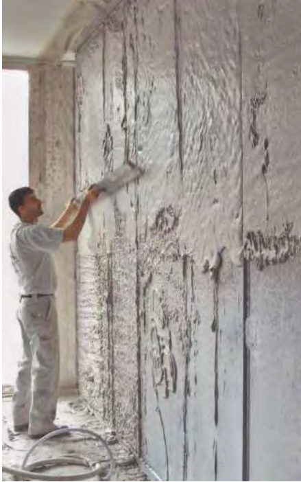
Εικόνα 6.3 Προσθήκη μιας στρώσης PCM σε γυψοσανίδα. Παρόλο που η γυψοσανίδα έχει πάχος μόνο 15mm, έχει γίνει επίστρωση με 3 κιλά από το υλικό. (Leydecker (2008))
