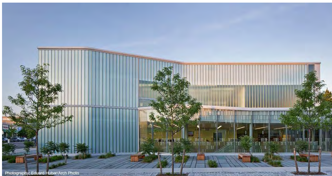
Εικόνα 5.6 Βιβλιοθήκη Queens στο Glen Oaks, New York ( https://www.tgpamerica.com/gallery/queens-library-at-glen-oaks )
