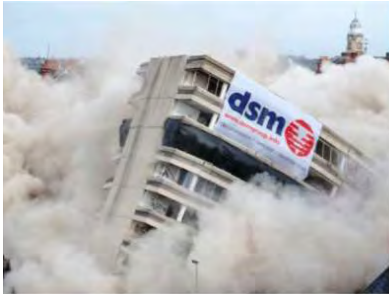
Εικόνα 7.2 Κατά την κατεδάφιση η έκθεση στα νανοϋλικά μπορεί να είναι ανεξέλεγκτη (Lee, Mahendra, Alvarez (2009))
