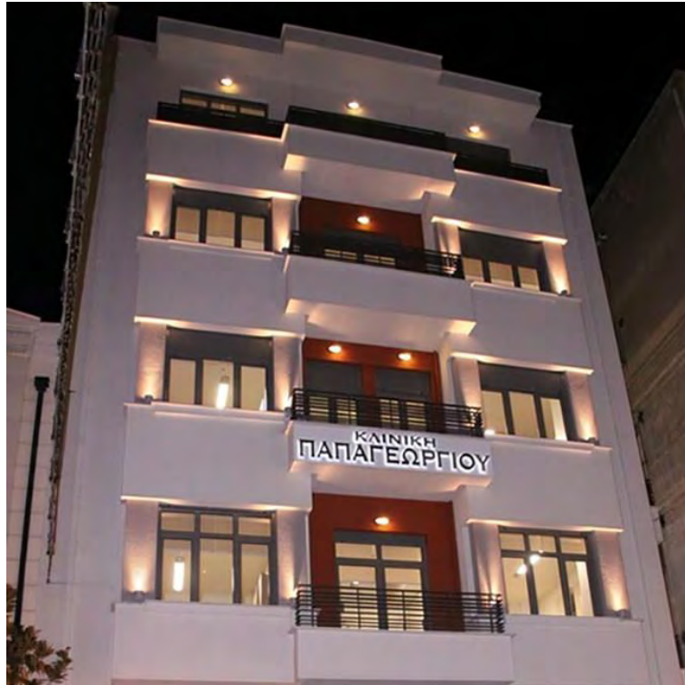
Εικόνα 19 Εικόνα Πρόσοψη κτιρίου νευρολογικής κλινικής Παπαγεωργίου
