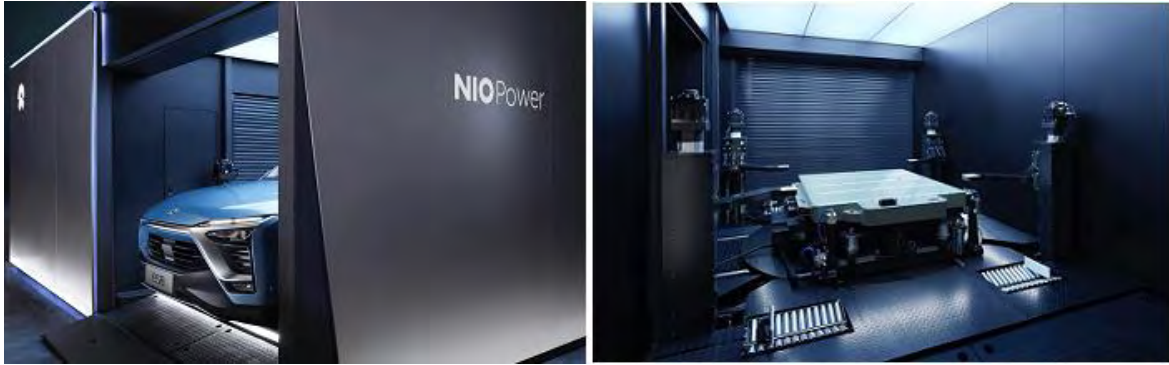
Εικόνα 28: Σταθμός ανταλλαγής μπαταρίας [23]
