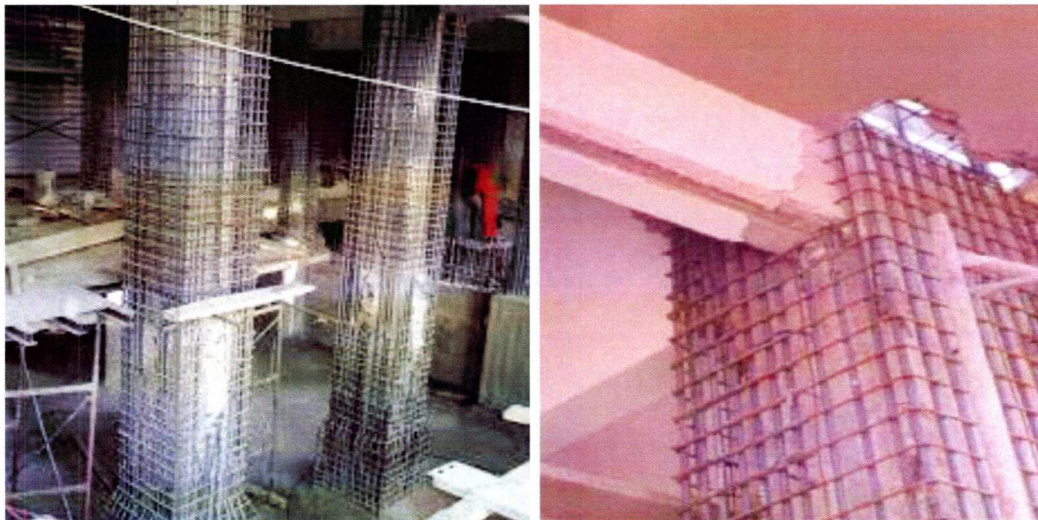
Εικόνα A.5.2: Ενισχυμένα υποστυλώματα με μανδύες
