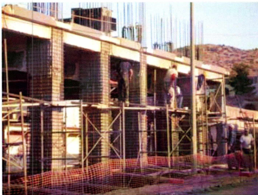
Εικόνα Α.5.1: Μανδύες οπλισμένου σκυροδέματος
