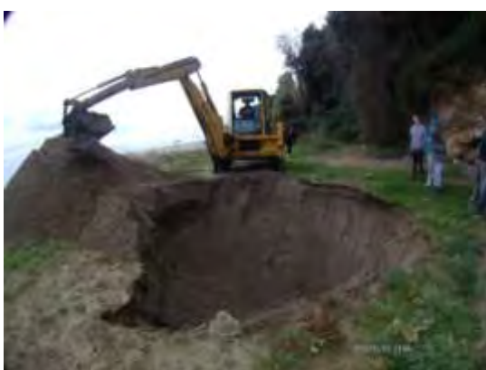
Εικόνα 10. Άνοιγμα τρύπας με τη βοήθεια εκσκαφέα στο σημείο ταφής
