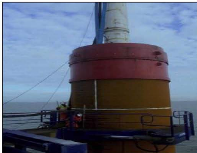
Σχήμα 3.14: Σφύρα έμψης μονοπασσάλου (Κουκούλας, 2014).
