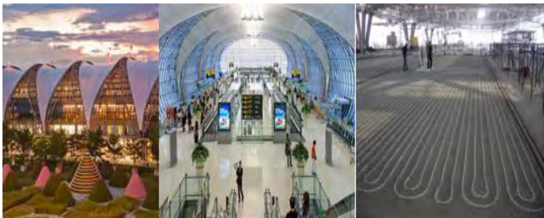
Εικόνα 2. 41 Bangkok international airport (radiant floor cooling)
