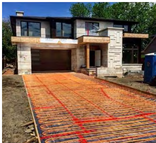
Εικόνα 2. 43 Ενδοδαπέδιο σύστημα θέρμανσης για αποφυγή πάγου στους δρόμους
