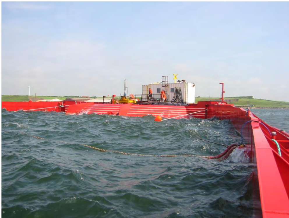
Εικόνα 1-6: Wave Dragon, Overtopping Device 1.5 to 12(MW)
