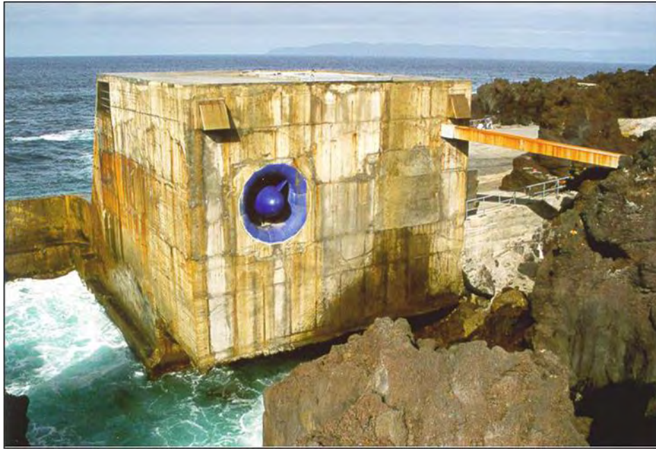
Εικόνα 1-3: Πίσω όψη της συσκευής 400 kW OWC στο νησί Pico, Azores, Portugal, 1999. Πηγή: Oscillating-water-column wave energy converters and air turbines: A review , Antonio Falcao, João C Henriques, (2016)
