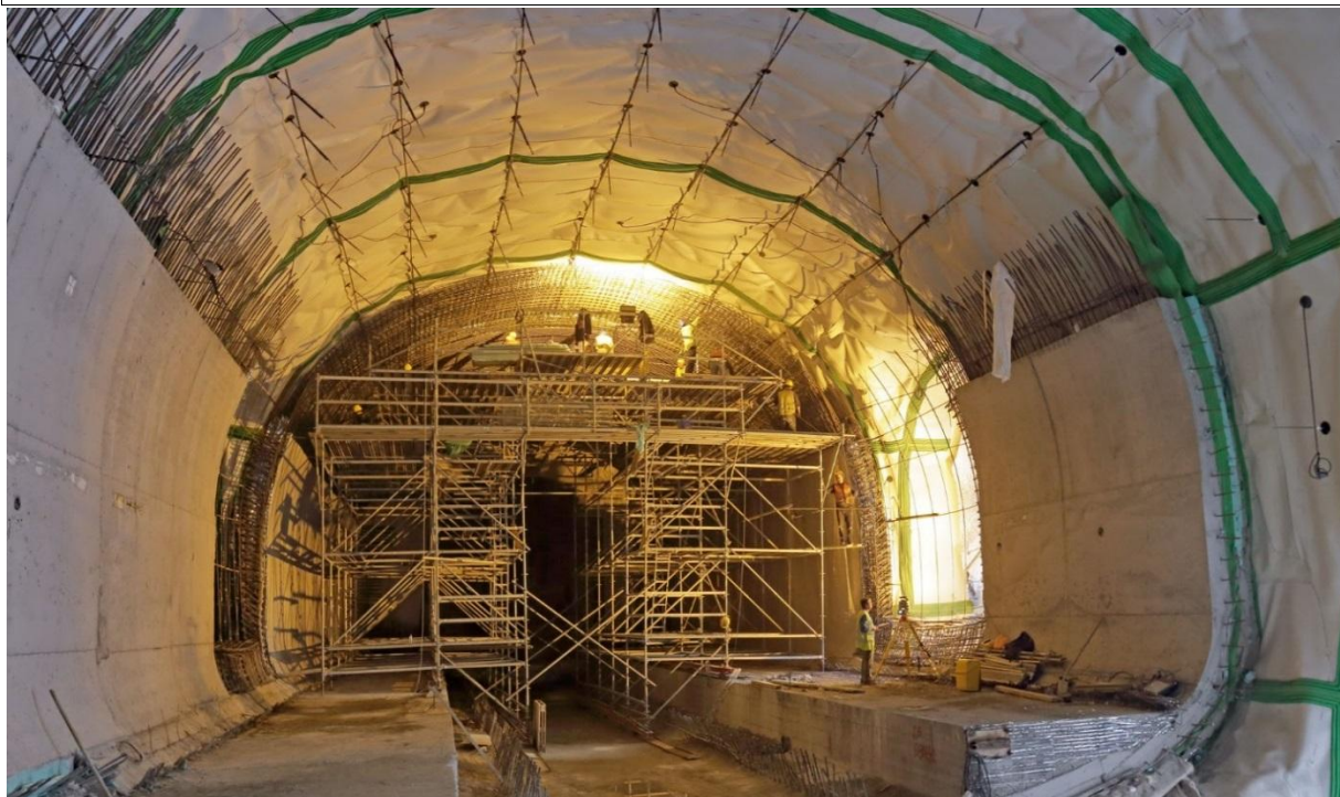
ΦΩΤΟ 23: ΤΟΠΟΘΕΤΗΣΗ ΟΠΛΙΣΜΟΥ ΜΟΝΙΜΗΣ ΕΠΕΝΔΥΣΗΣ ΘΟΛΟΥ ΤΗΣ ΣΗΡΑΓΓΑΣ ΤΟΥ ΣΤΑΘΜΟΥ - 2017
