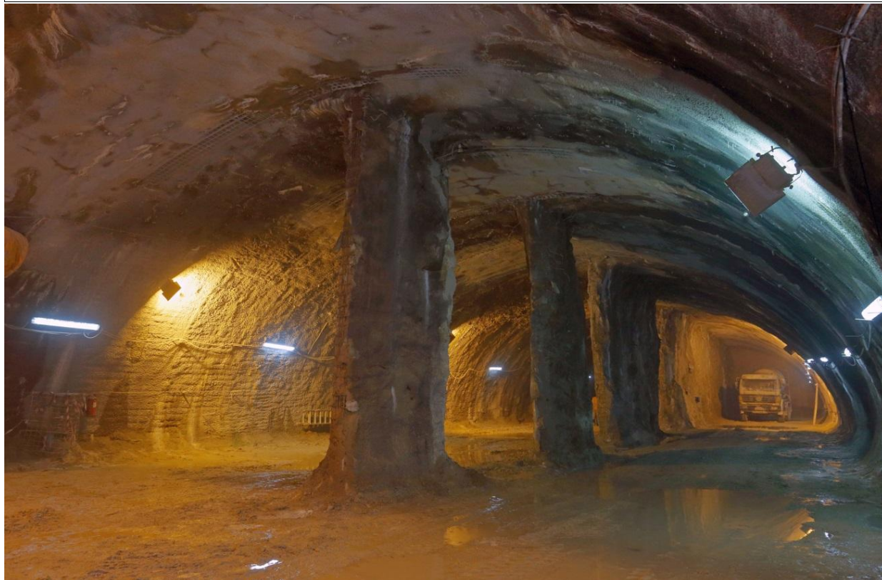
ΦΩΤΟ 21: ΚΑΘΑΙΡΕΣΗ ΜΕΣΑΙΟΥ ΤΟΙΧΩΜΑΤΟΣ ΒΟΡΕΙΑΣ ΣΗΡΑΓΓΑΣ ΣΤΑΘΜΟΥ - 2015
