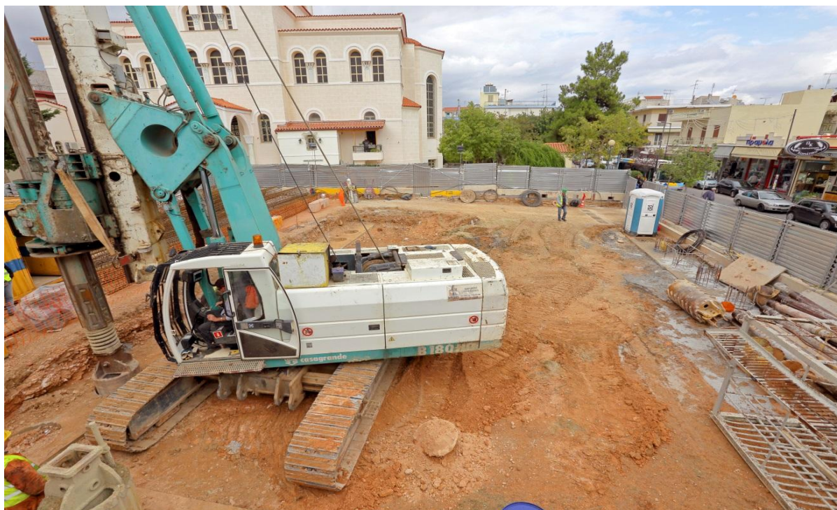
ΦΩΤΟ 39: ΔΙΑΤΡΗΣΗ ΠΑΣΣΑΛΩΝ – 2014
