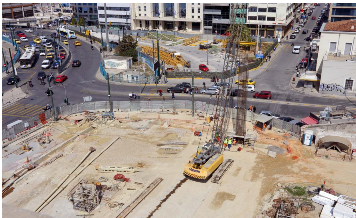
ΦΩΤΟ 26: ΤΟΠΟΘΕΤΗΣΗ ΣΙΔΗΡΟΥ ΟΠΛΙΣΜΟΥ ΔΙΑΦΡΑΓΜΑΤΙΚΟΥ ΤΟΙΧΟΥ - 2016
