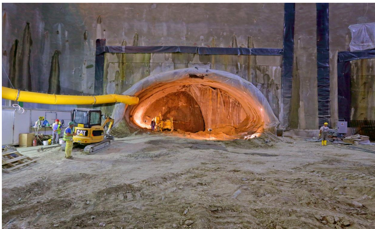
ΦΩΤΟ 14 : ΑΠΟΨΗ ΕΡΓΑΣΙΩΝ ΕΚΣΚΑΦΗΣ ΣΗΡΑΓΓΑΣ NATM (ΦΑΣΗ Α1 ΕΚΣΚΑΦΗΣ) - 2014
