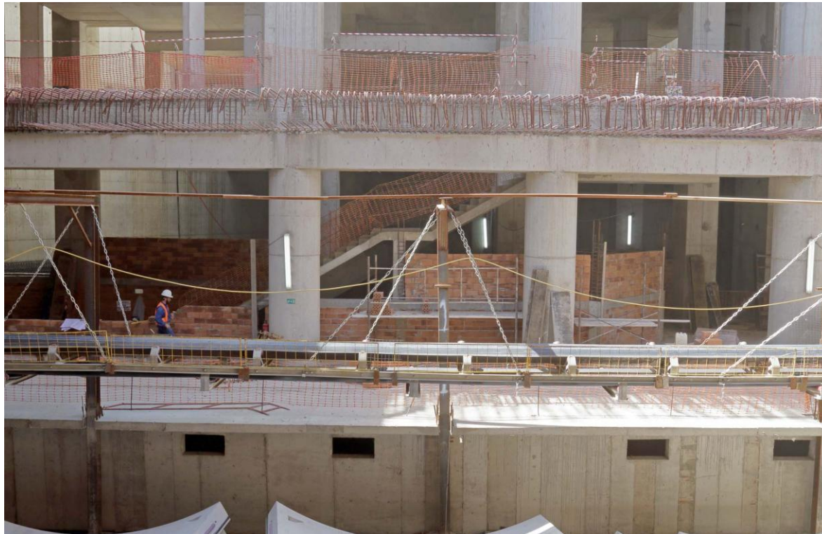
ΦΩΤΟ 10: ΑΠΟΨΗ ΕΡΓΑΣΙΩΝ ΤΟΙΧΟΠΟΙΙΑΣ ΣΤΟ ΕΠΙΠΕΔΟ ΑΠΟΒΑΘΡΩΝ ΤΟΥ ΣΤΑΘΜΟΥ - 2016
