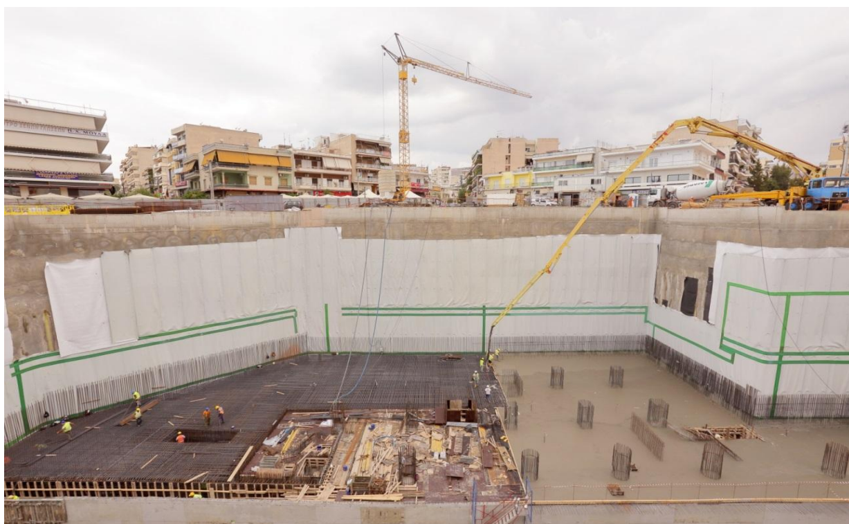
ΦΩΤΟ 8:: ΣΚΥΡΟΔΕΤΗΣΗ ΠΛΑΚΑΣ ΕΠΙΠΕΔΟΥ ΑΠΟΒΑΘΡΩΝ - 2014
