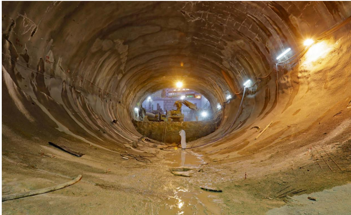
ΦΩΤΟ 32: ΑΠΟΨΗ ΒΑΣΙΚΗΣ ΣΗΡΑΓΓΑΣ NATM ΣΤΑΘΜΟΥ - 2016
