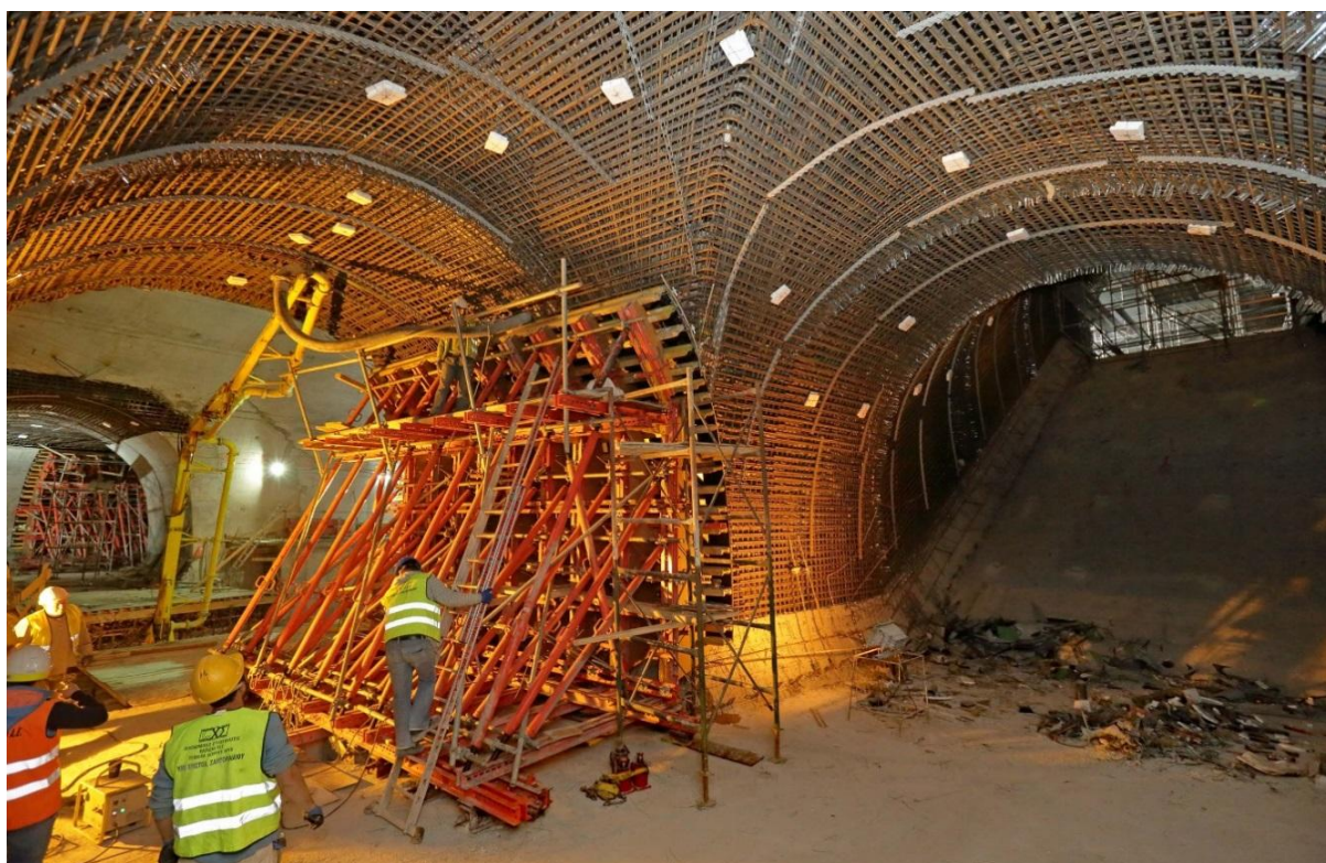
ΦΩΤΟ 34: ΕΡΓΑΣΙΕΣ ΚΑΤΑΣΚΕΥΗΣ ΜΟΝΙΜΗΣ ΕΠΕΝΔΥΣΗΣ ΝΟΤΙΑΣ ΣΗΡΑΓΓΑΣ ΚΛΙΜΑΚΟΣΤΑΣΙΟΥ - 2017
