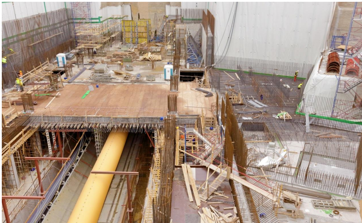
ΦΩΤΟ:2 ΑΠΟΨΗ ΣΚΥΡΟΔΕΤΗΜΕΝΗΣ ΠΛΑΚΑΣ ΕΠΙΠΕΔΟΥ ΕΚΔΟΣΗΣ ΕΙΣΙΤΗΡΙΩΝ - 2014
