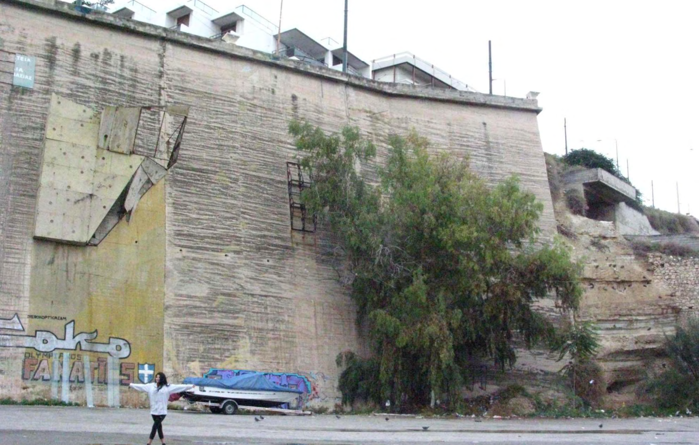
Ο υπάρχων τοίχος αντιστήριξης από μπετόν που στη συνέχεια του θα τοποθετηθεί η κατασκευή μας
