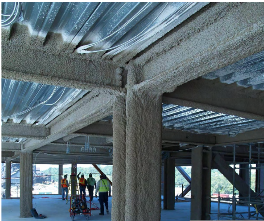
Εικόνα 21: Φωτογραφία ενός τυπικού Sprayed Fire Resistive Material σε κτίριο
