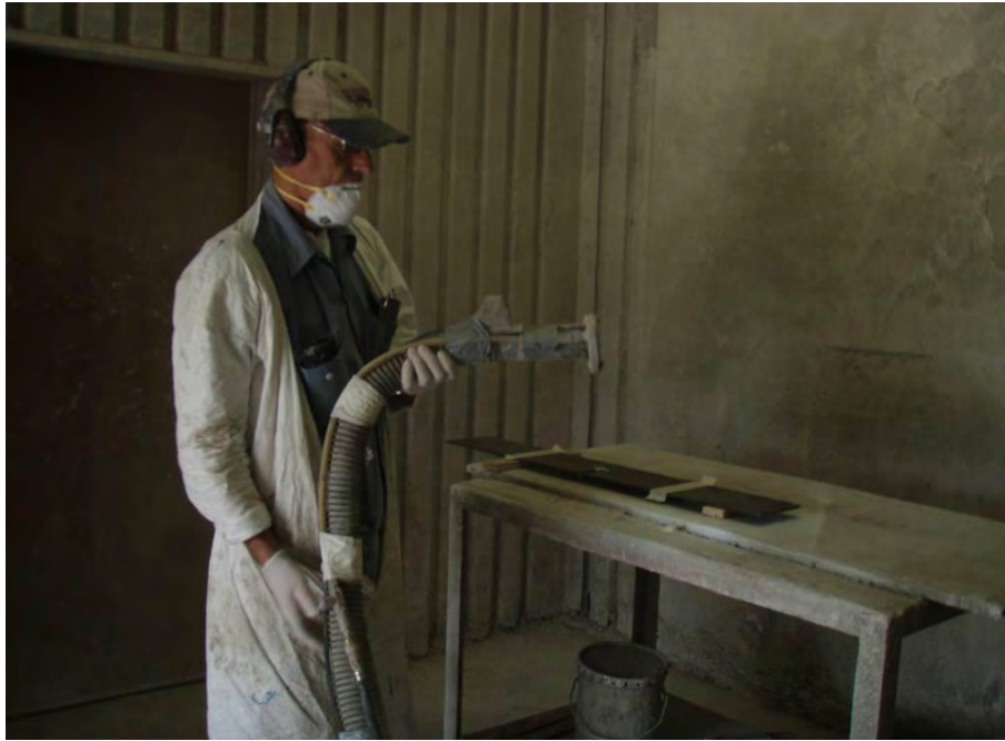
Εικόνα 19: Υγρό μείγμα εκτοξευόμενου πυράντοχου υλικού έτοιμο για εφαρμογή στην επιφάνεια του μεταλλικού δομικού μέλους (πηγή: https://cdn.ymaws.com/www.sfpe.org )
