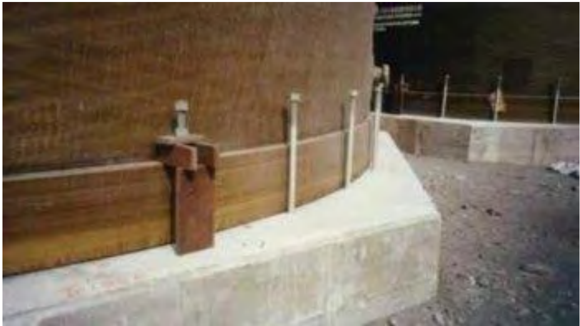
Εικόνα 1.3: Αγκυρωμένη σε θεμέλιο δεξαμενή.
