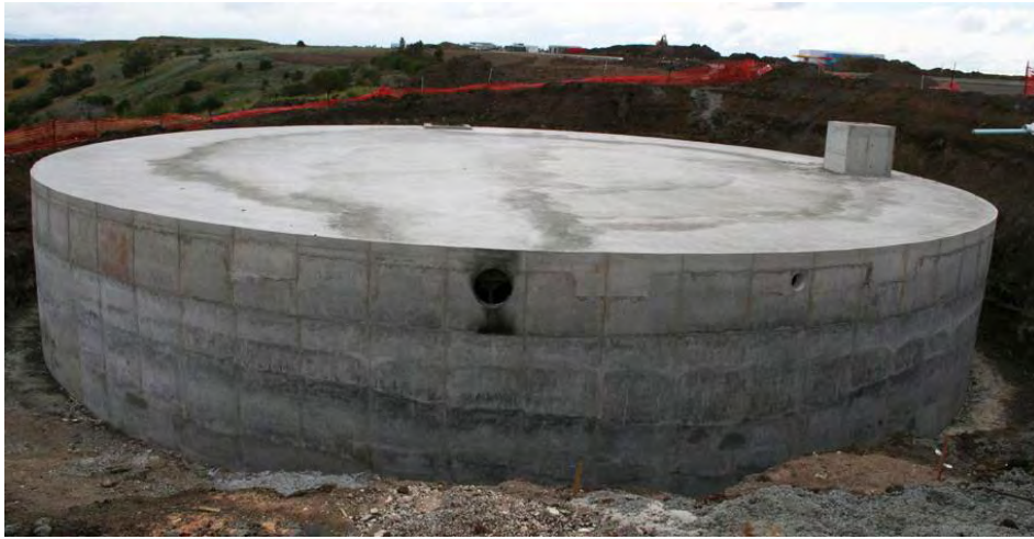
Εικόνα 1.1: Υπόγεια δεξαμενή αποθήκευσης υγρών από οπλισμένο σκυρόδεμα (πριν την επίχωση)
